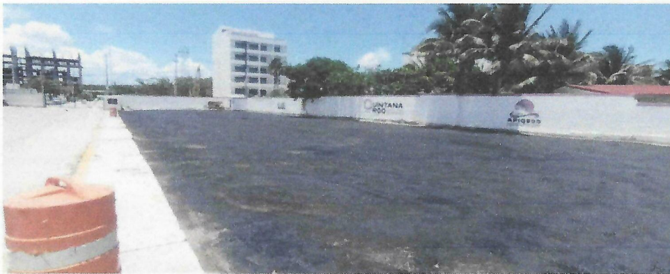
Pavimentación estacionamiento del recinto de Puerto Morelos
